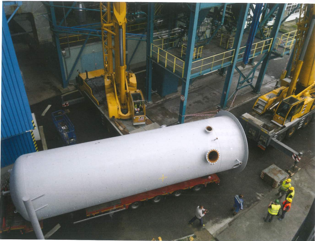
Dovoz první akumulární nádrže
